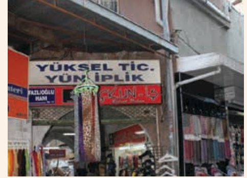
Hanın günümüze kalan giriş kapısı / Verbleibendes Eingangstor des Hanbaus
