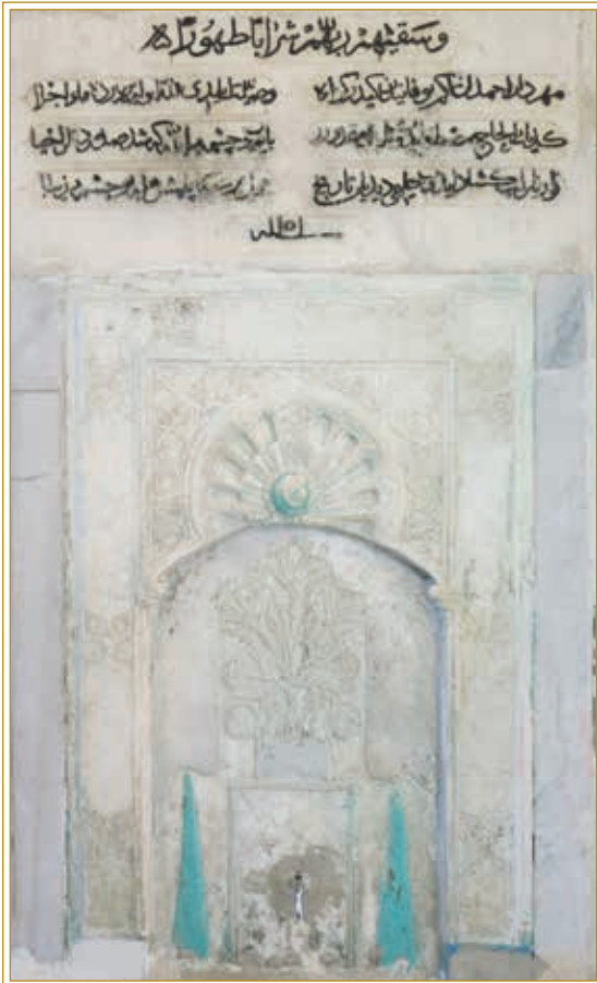
Görsel 71. Çeşmenin kapı tarafındaki cephesi. (20 Ağustos 2021)
