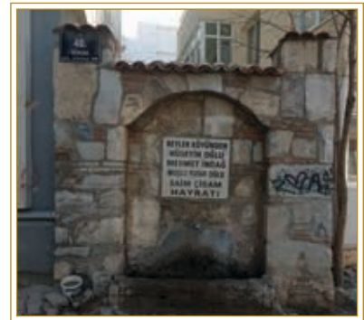
Görsel 331. Çeşmenin ön cepheden görünümü. (24 Aralık 2022)
