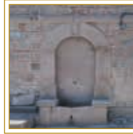
Kurtuluş Mahallesi, Parmakbatıran Caddesi ile Taksim Caddesi birleşimi. 528 ada 15 parseldeki kargir evin duvarındadır.
