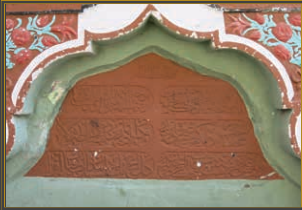
Görsel 146. Çeşmenin yapım kitabesinin görünümü. (8 Ağustos 2021)
