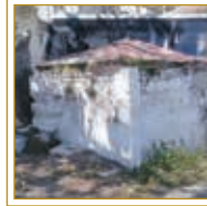
Kurtuluş Mahallesi, Parmakbatıran Caddesi sonunda Akropol Caddesi ile Sipahi Sokağı'nın birleşimi. 537 ada 1 parseldeki çeşme 5 m2 tapu alanına sahip 93 çeşme bakımsız haldedir.
