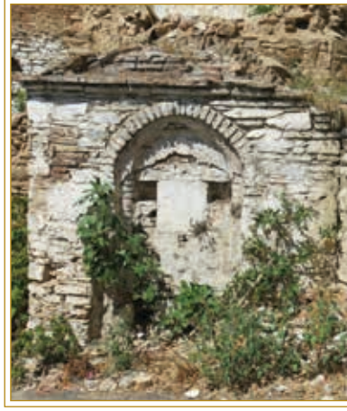
Görsel 131. Küplü Çeşme'nin ön cepheden görünümü. (13 Ağustos 2021)
