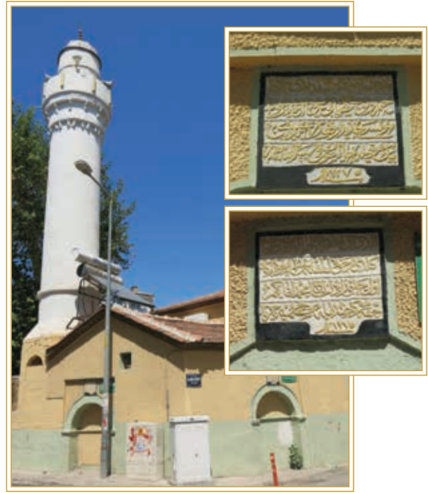
Görsel 304. Çeşmenin ve Çınarlı Camii'nin görünümü. (18 Ağustos 2021)
