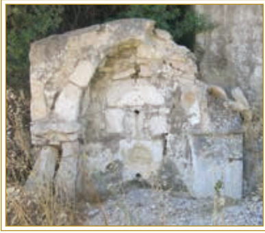
Görsel 277. Köy Çeşmesi'nin ön cepheden görünümü. (9 Ağustos 2021)
