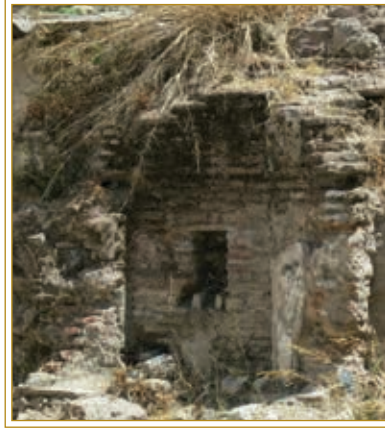
Görsel 23. Sokak Çeşmesi'nin görünümü. (8 Ağustos 2021)
