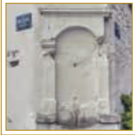
Kurtuluş Mahallesi, Yeni Çeşme Sokağı ile Gündoğdu Sokağı'nın birleşimi. 531 ada 5 parseldeki çeşme 1m2 tapu alanına sahiptir 92 . Duvar çeşmesi görünümünde olup bakımsız haldedir.
