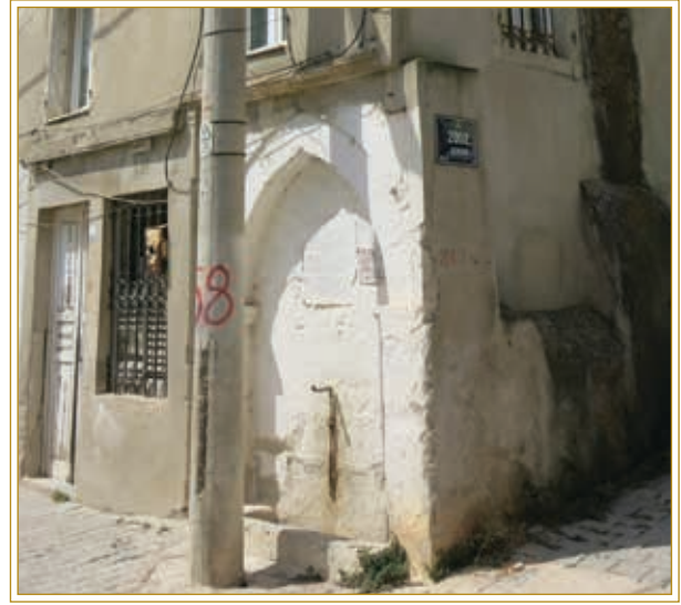
Görsel 229. Memiş Çeşmesi'nin ve üzerindeki yapının görünümü. (5 Ağustos 2021)
