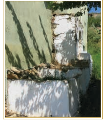
Görsel 125. Çeşmeye bitişik halde inşa edilmiş yapı ve çeşmenin görünümü. (13 Ağustos 2021)
