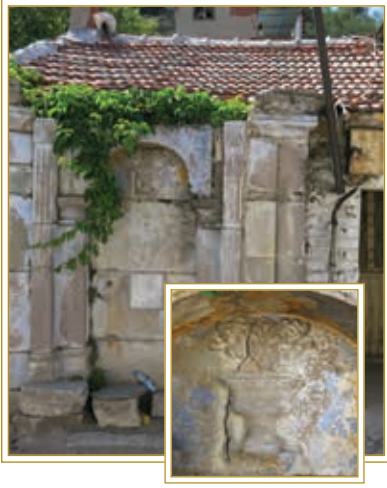
Görsel 150. Çeşme ve üzerindeki vazo kabartması. (12 Ağustos 2021)
