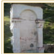
Selçuk Mahallesi, Helvacı Dede mevkii. Çeşme bakımsız haldedir.
