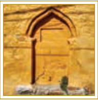
Talatpaşa Mahallesi. Bakımsız haldeki çeşme kemerli yapıdadır. Kitabe kısmı boştur.
