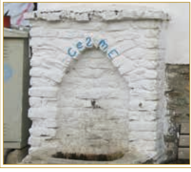
Görsel 345. Sokak Çeşmesi'nin görünümü. (13 Ağustos 2021)
