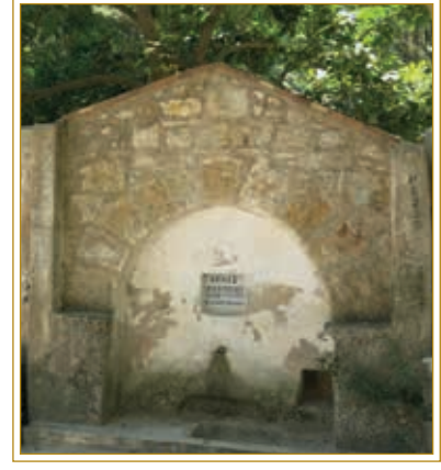
Görsel 444. Akmaz Çeşme'nin görünümü. (4 Ağustos 2021)
