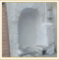
Talatpaşa Mahallesi, Kılıçali Sokağı. 450 ada 22 parseldeki avlulu kargir evin giriş duvarındadır.
