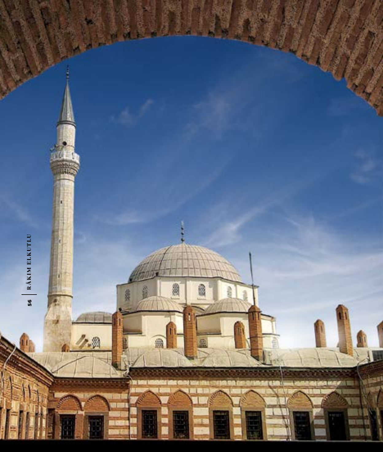
Hisar Camii'nin batı tarafından görünüşü
