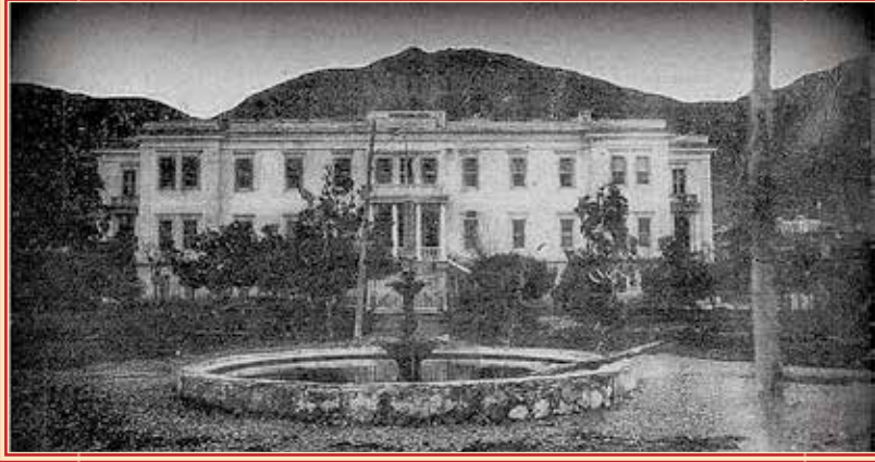
Şekil 52. Manisa Mutasarrıflığı Binası
