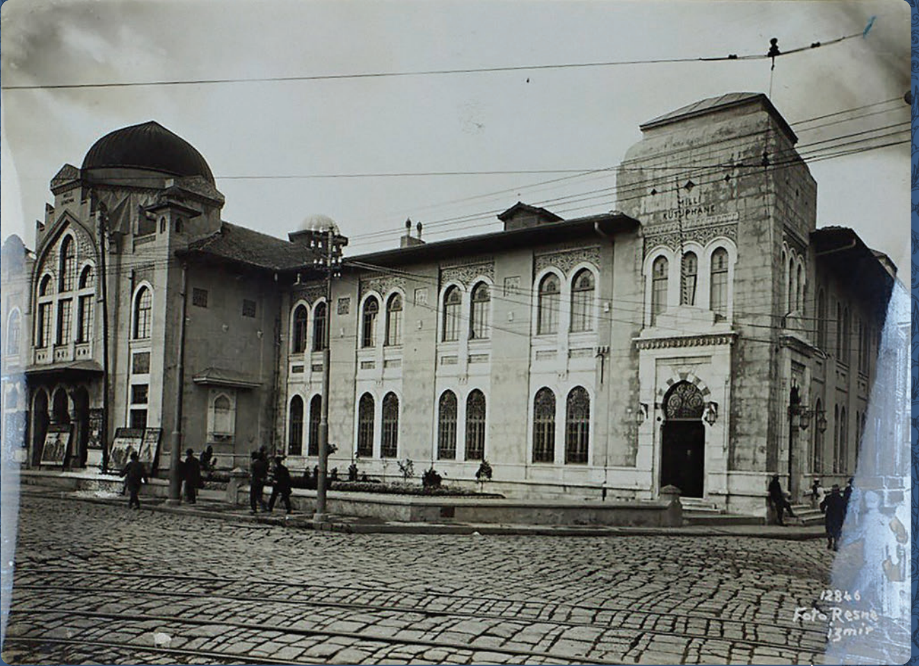
Fotoğraf 12. İzmir Millî Kütüphanesi'nin 1933 Yılında Tamamlanan Binası 8
