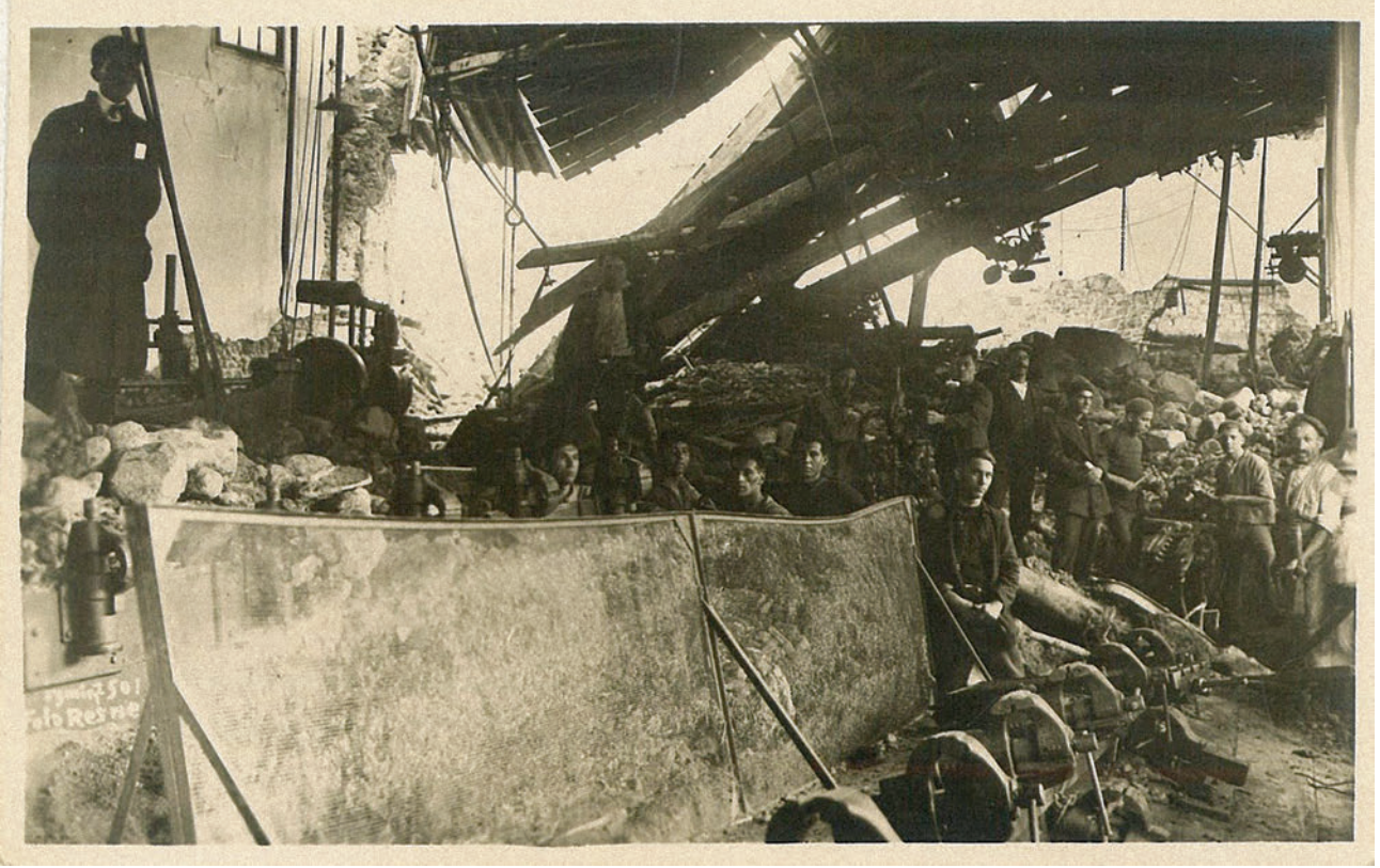
Fotoğraf 39. Sel Sonrasında Tesviye ve Torna Atölyesinin Durumu 25
